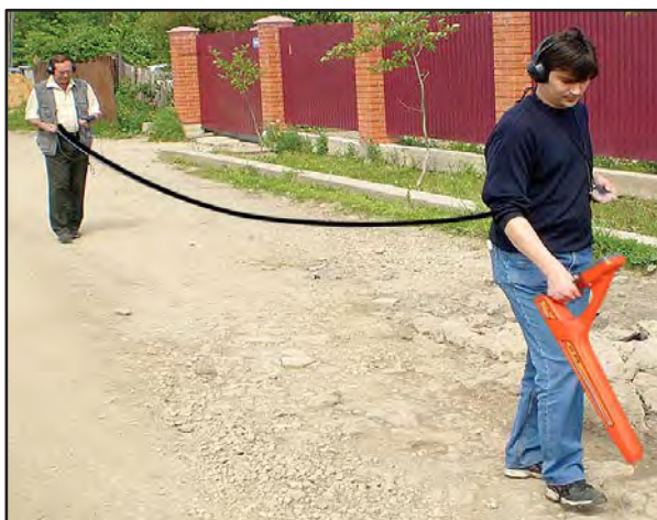
Рисунок В.4. Определение дефектов изоляции при помощи ДОДК-117.
