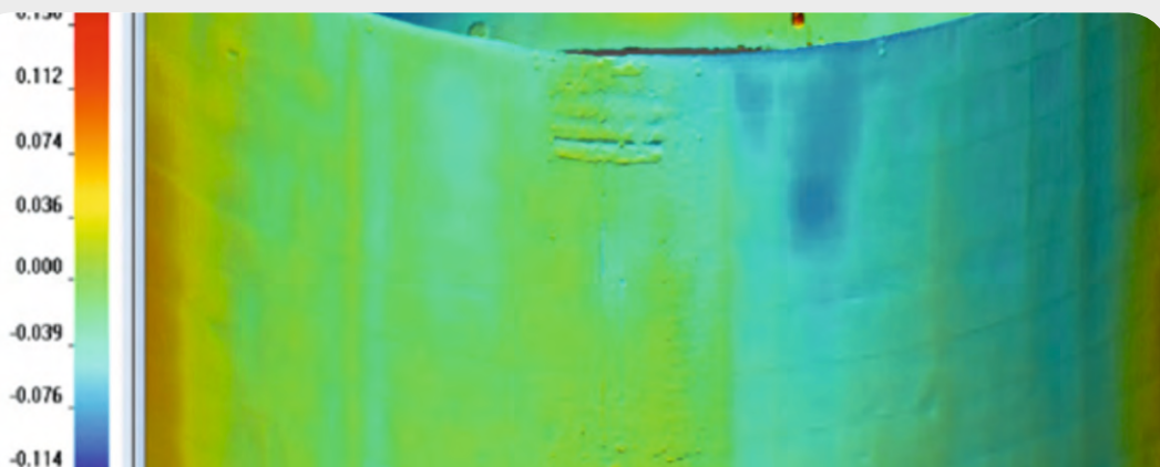
Обследование инженерных коммуникаций и емкостей (Геомониторинг)
